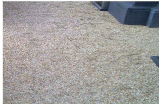
LPS-E onder grind op een balkon
